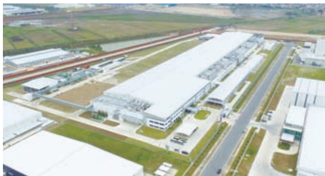
敷地面積：102,909㎡ 建屋面積：35,000㎡
