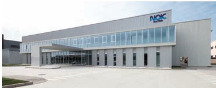
NOK（無錫）ウォータートリートメントテクノロジー Co.,Ltd. （中国 江蘇省無錫市）
